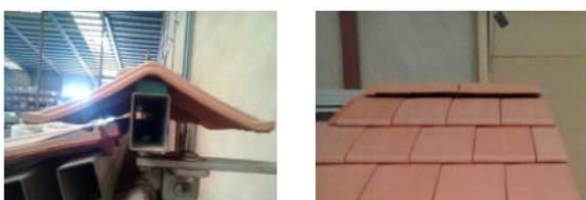
Montaż gąsiorów Q90 podczas krycia dachówkami Planum (TI)
