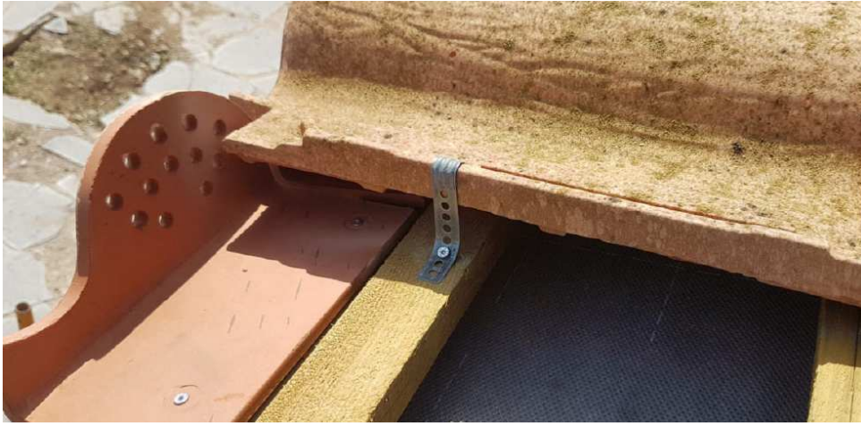
CAM62 Klamra/spinka okapowa do dachówek z rąbkiem
