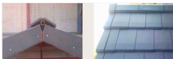
Montaż gąsiorów Q120 podczas krycia dachówkami Planum (TI)
