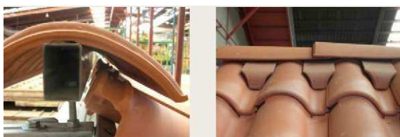
Montaż gąsiorów Q02 podczas krycia dachówkami typu mieszanego Mixed (TG-TP)
